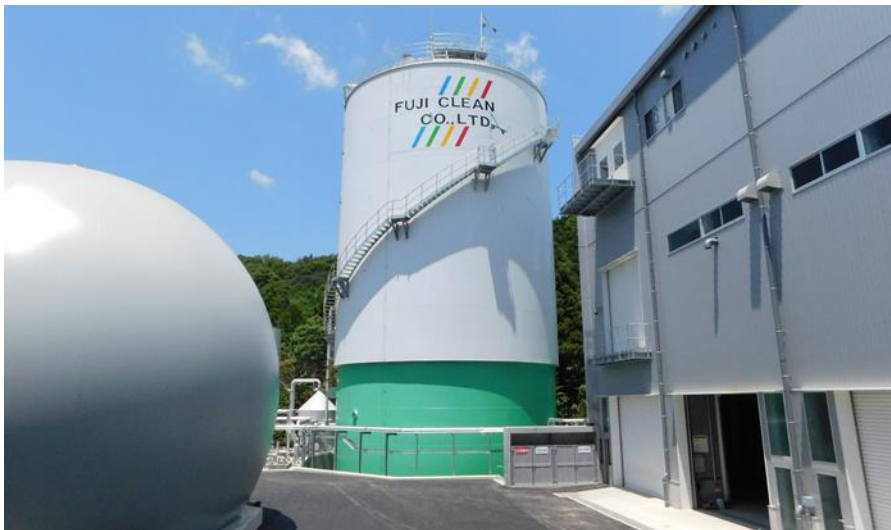
図1 縦型乾式メタン発酵施設の外観
