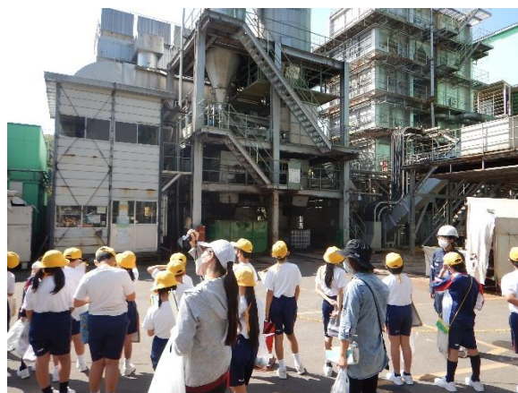
焼却処理施設
