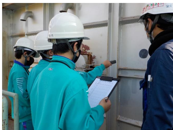
焼却施設の点検業務を体験
