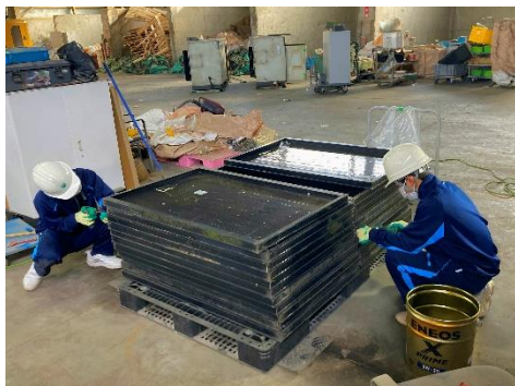
(太陽光パネルのフレームの分解作業)
