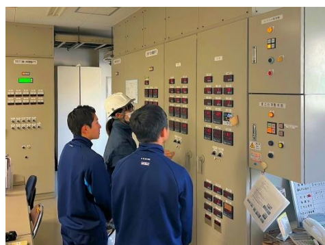
（浸出水処理の各メーター数値点検）
